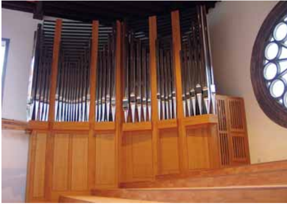
Orgelgehäuse und Fußboden aus Kirschbaumholz; Stahl-Lamellen als „Schleierbretter“
