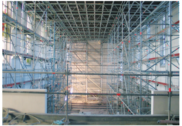
Eingerüstete Kirche (alle Fotos von Rudolf Kohler)
