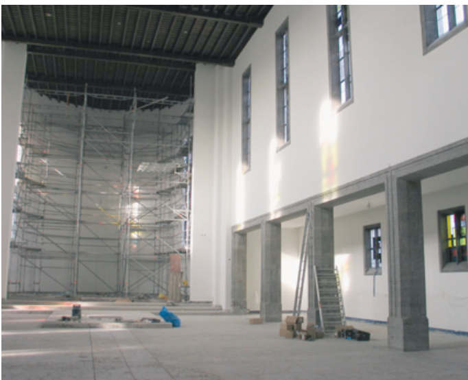
Das Gerüst wird abgebaut
